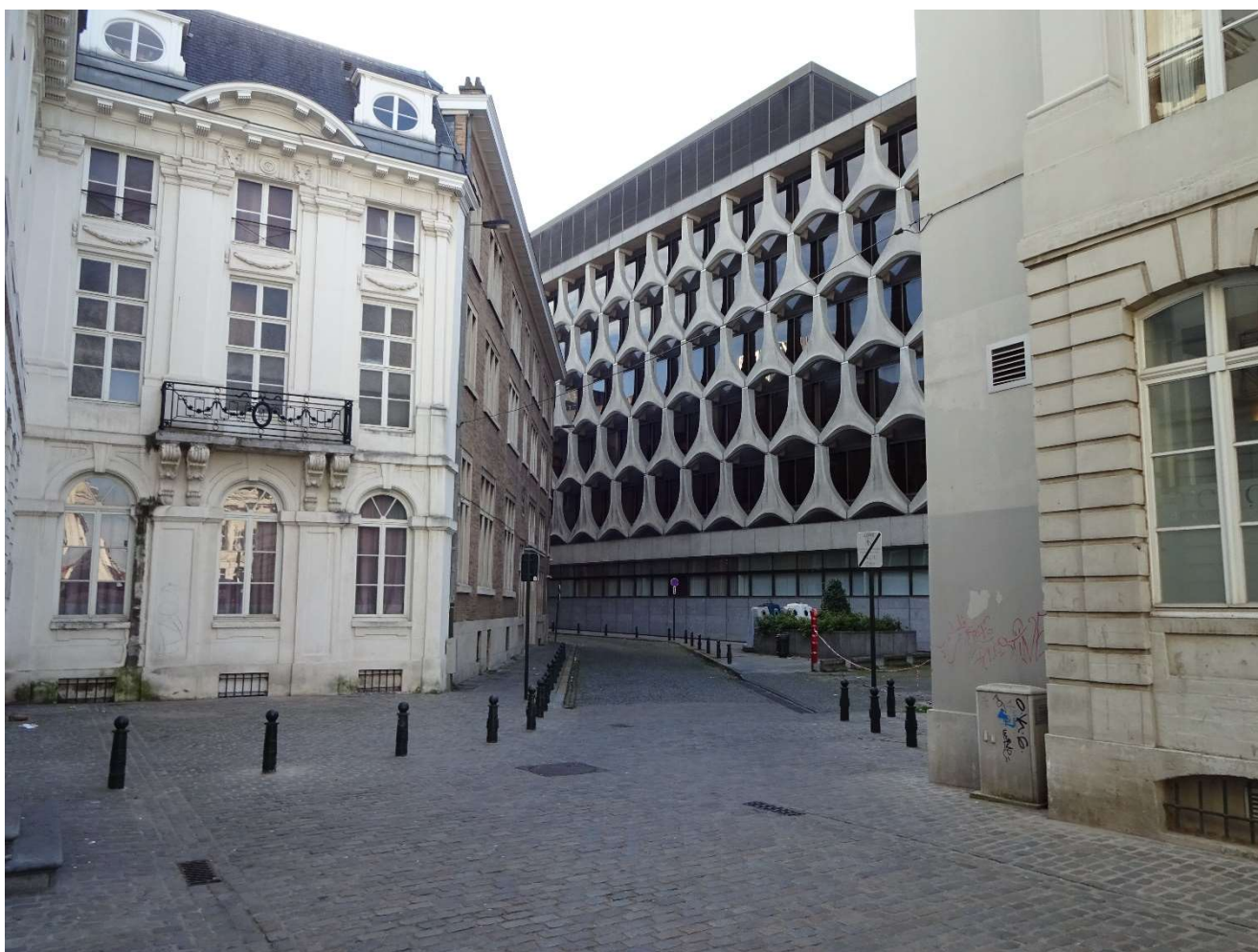
La rue du Persil, côté place des Martyrs, avec le temple maçonnique dans le bâtiment à gauche, l'ancien bâtiment de la banque et la librairie CFC à droite.
