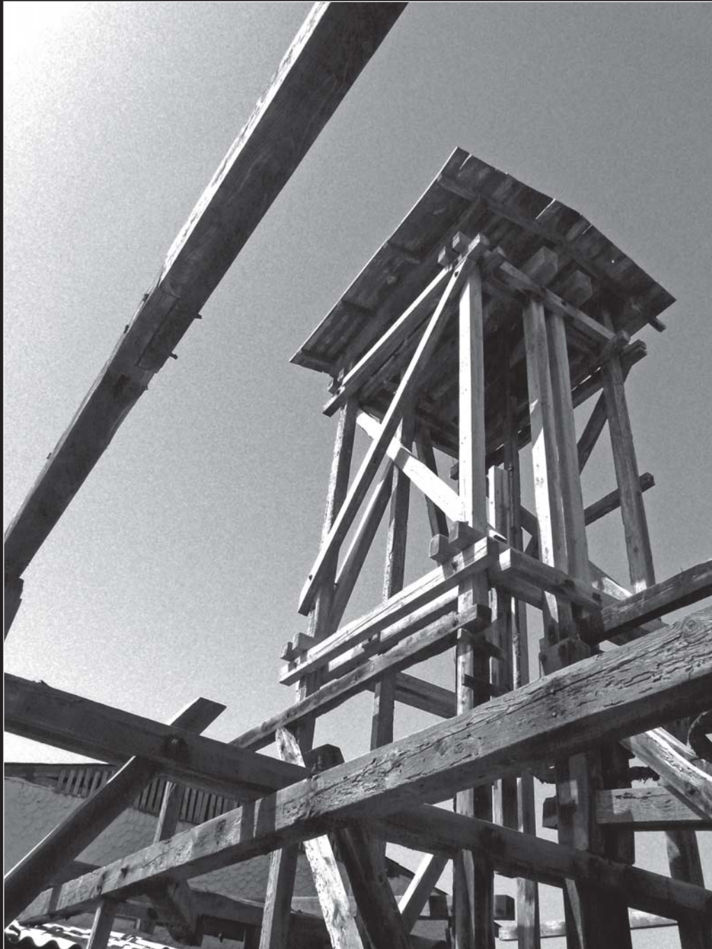
Cabo Verde: Salinas Pedra do Lume, verlaten zoutmijnen op het eiland Sal.
